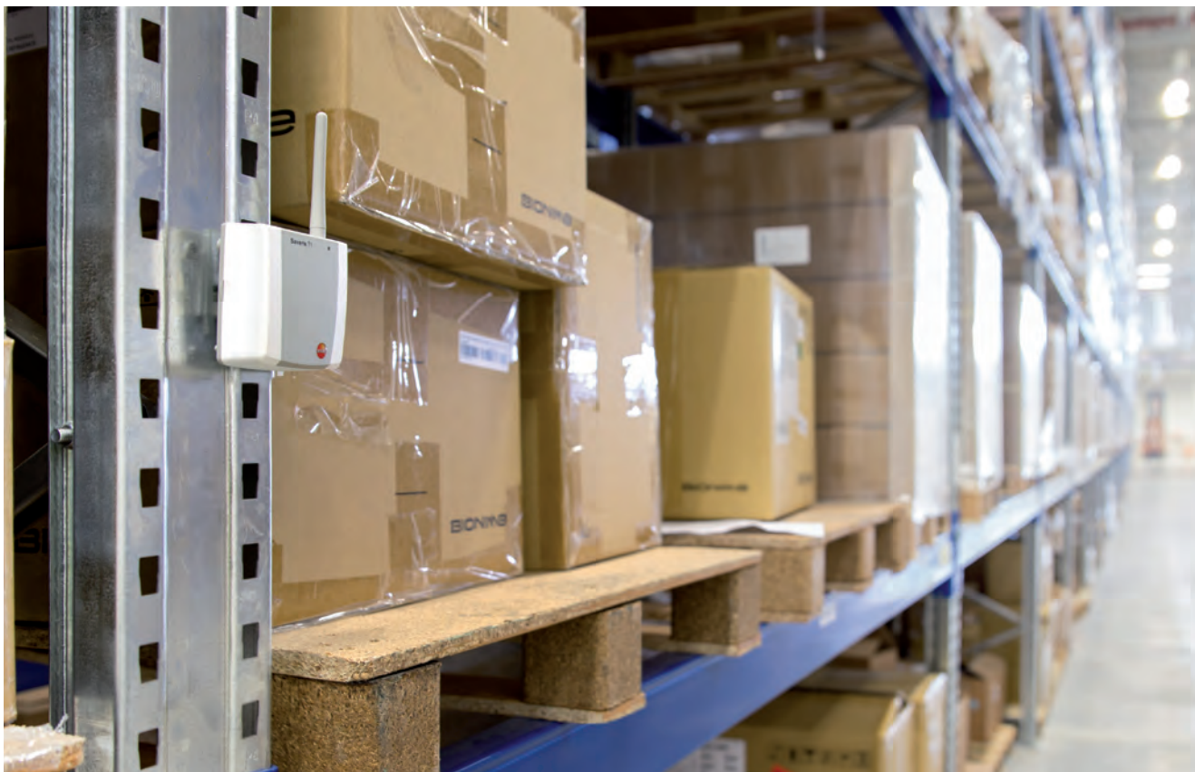
Мониторинг температуры в критической контрольной точке с testo Saveris.
